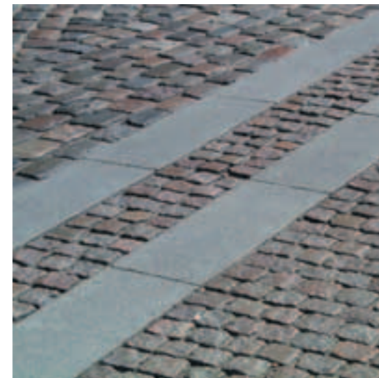
Torve og pladser i Middelalderbyen belægges primært med granit, der med sin karakter og detaljering sammenbinder områderne i den historiske bydel.
